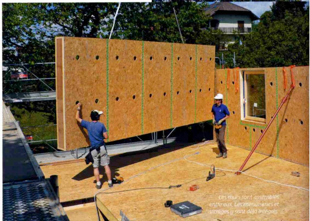
*Les murs sont assemblés entre eux. Les menuiseries et vitrages y sont déjà intégrés.*
