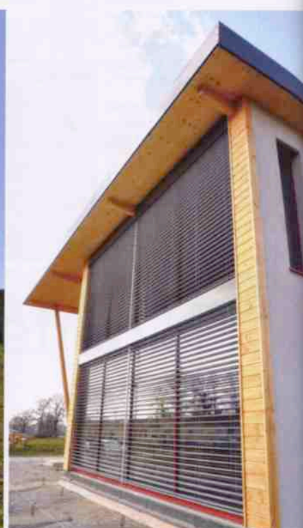
Maison Passive à Bellac, réalisation Cotralim, voir fiche page 90.
