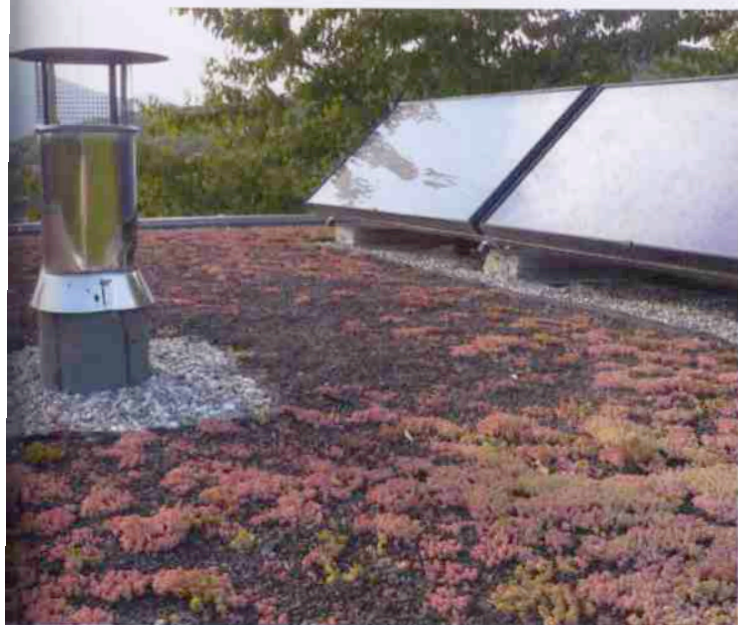
La végétalisation de toiture permet, entre autre, d'apporter une inertie utile au confort thermique.
