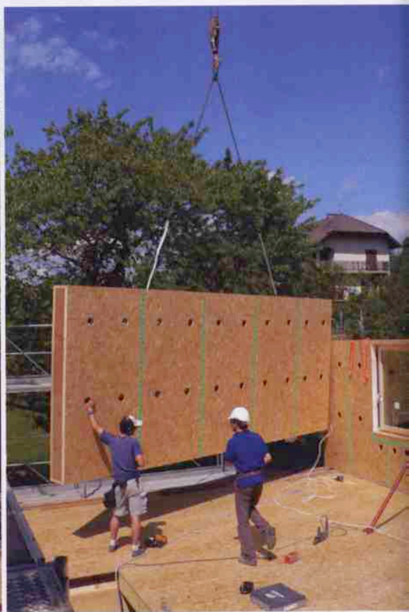
Les murs à ossature de 30 cm d'épaisseur ont été fabriqués et montés en atelier par Etamines et livrés sur site avec leurs menuiseries. Les trous que l'on aperçoit sont les ouvertures ménagées pour l'insufflation de ouate de cellulose sur site. Ils sont ensuite bouchés et étanchéifiés.
