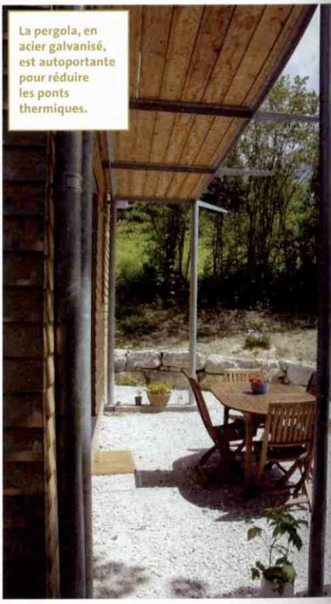
La pergola, en acier galvanisé, est autoportante pour réduire les ponts thermiques.
